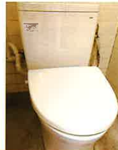
ハケ岳キャビン男子トイレ便器交換工事 工事完了日：2024年9月27日 施工業者：黒沢燃料
