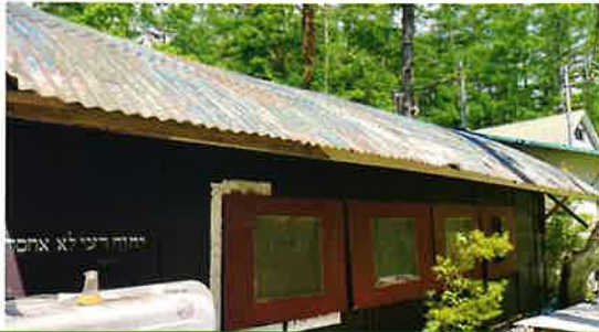
ハケ岳キャビン女子トイレ天井修繕工事/ チャペル屋根雨漏り修繕工事/カナン屋根修繕工事 工事期間：2024年6月4日、25日、26日
