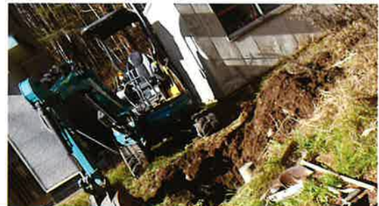
「にう」キャビン 浄化槽地中管修復工事 工事完了日：2024年11月22日 施工業者：黒沢燃料
